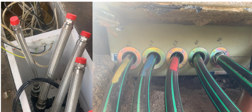
Figur 11 Sump under mätare
