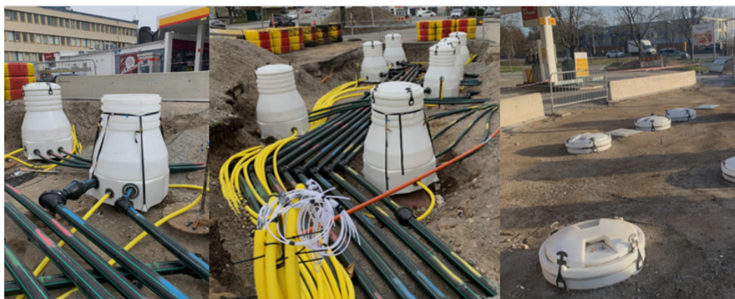
Figur 6 Installation av sumpar till manluckor
