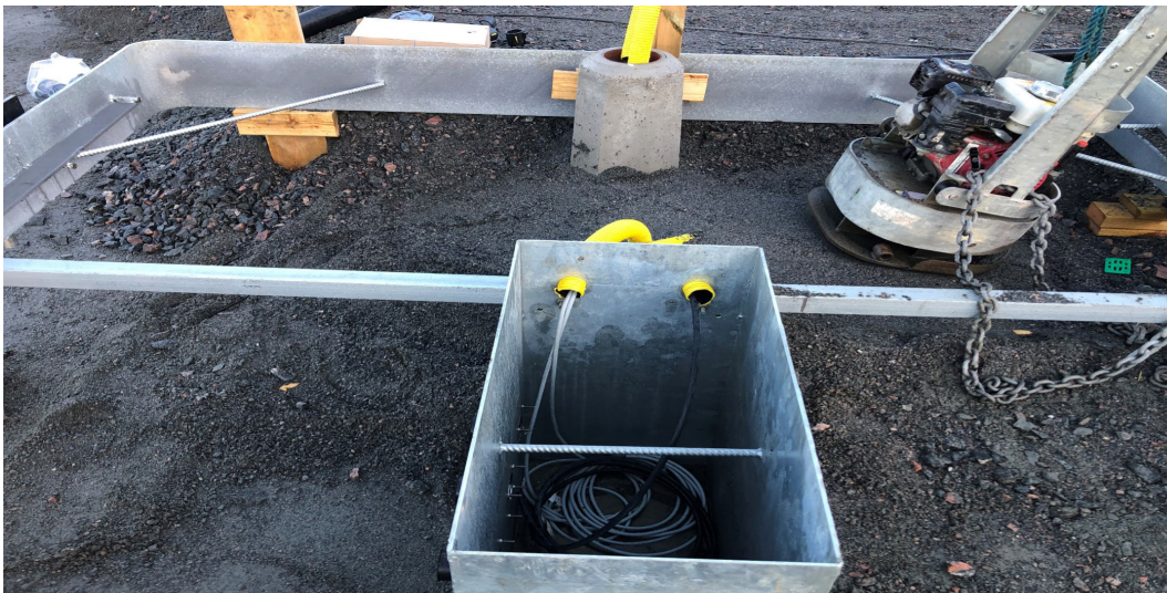
Figur 10 Pumprefug med sump för mätarskåp
