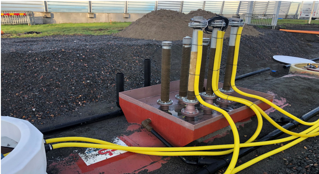
Figur 2 Dubbelmantlad cistern med inre rördragning, centralpåfyllning
