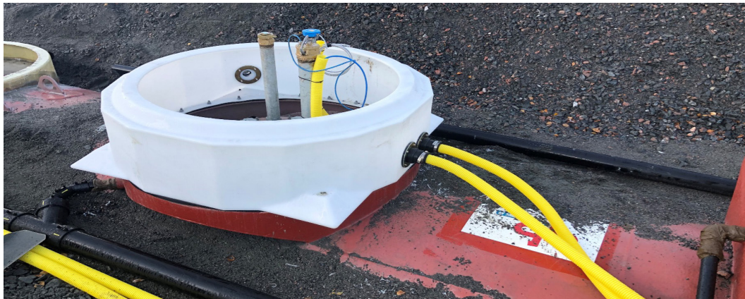
Figur 3 Del av sump monterad på cistern
