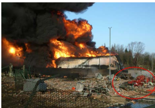
Bild 32: Courtesy to Dr Niall Ramsden, LASTFIRE Group. Fotografi från Buncefield branden december 2005. Bilden visar en förstörd fast brandpumpsinstallation som förstördes vid en explosionen och sedan blev obrukbar i den efterföljande branden.
