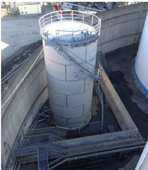
Bild 3. Flera cisterner inom invalning med cisternspecifik avgränsning, s.k. "kvartersinvalning".
