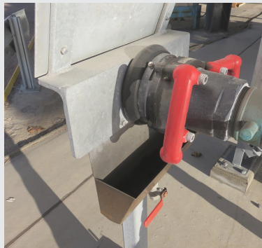
Figur 5 Detalj av spillskydd vid slangupphängning
