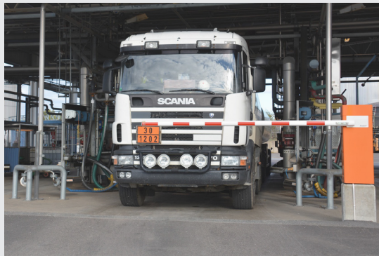
Figur 4 Exempel på ivägkörningsskydd med bom
